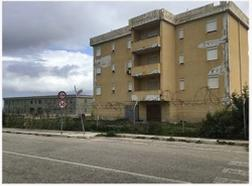
Quest'edificio è uno dei più degradati del lotto. Dall'immagine, sono visibili crepe all'intonaco soprattutto nel cornicione, dove addirittura l'intonaco non è presente, inoltre, nel corso del tempo si sono staccati altri pezzi d'intonaco nel resto della facciata.
